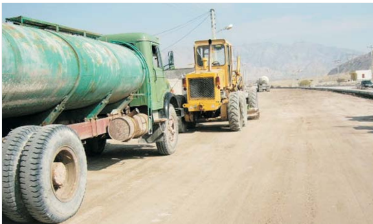
■ ماشین آلات شهرداری بستک در حال زیرسازی و آسفالت بلوار آیت ا... خانه ای
